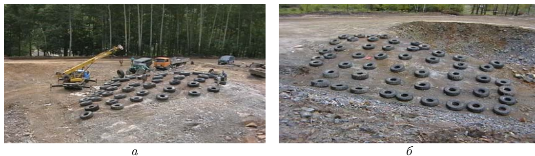
Рис. 3. Укрытие в виде мата из автомобильных шин: а – укладка шин автокраном; б – общий вид укрытия
