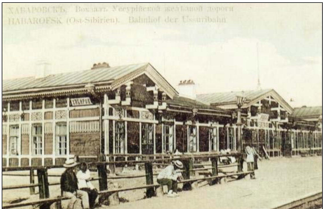
Железнодорожный вокзал станции Хабаровск, 1897г. (вид с перрона)
