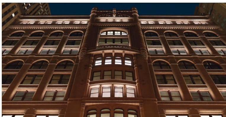
Рис.2. Локальное освещение фасада.
