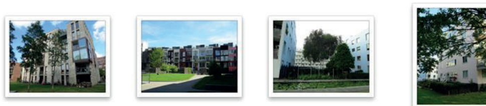
Рис. 2. Приемы формирования жилых дворов: двор для пешеходов; развитое озеленение территории; наличие частных мини-участков у жителей первых этажей с различной степенью их открытости в пространство двора
