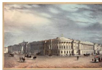
Рис. 6. Здание Сената и Синода.
