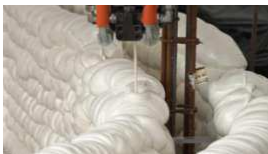
Рисунок 5. Процесс печати с использованием пенополиуретана (технология несъемной опалубки) [4]
