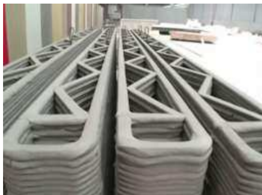
Рисунок 4. Процесс печати пустотелой стены с применением специализированной цементной смеси [4]
