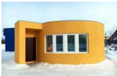
Рисунок 2. Первое полностью отпечатанное на строительной площадке здание площадью 37 кв. м. [2]
