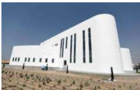
Рисунок 3. Г. Дубаи (ОАЕ), самое большое здание, отпечатанное непосредственно на строительной площадке [3]
